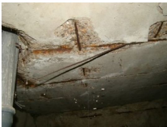
Рис. 3. Коррозия продольной рабочей арматуры
