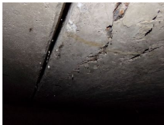
Рис. 5. Повреждения аварийных плит перекрытия
