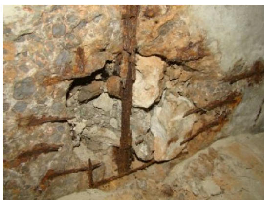
Рис. 3. Коррозия продольной рабочей арматуры
