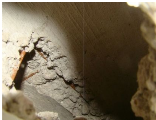
Рис. 4. Участки с неуплотнённым бетоном, непробетонированные ребра плит между пустотами на отдельных участках
