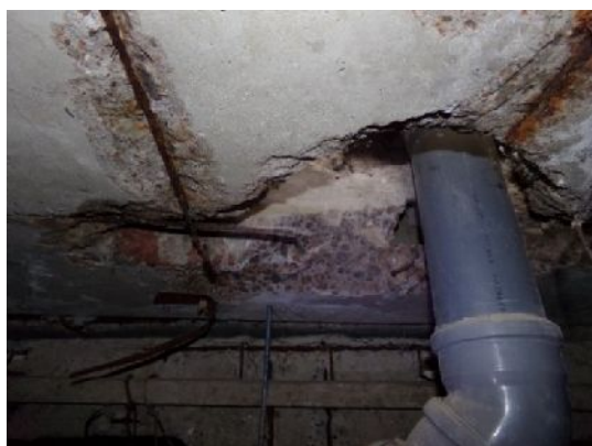
Рис. 2. Неоформленные отверстия в зонах прохода инженерных коммуникаций
