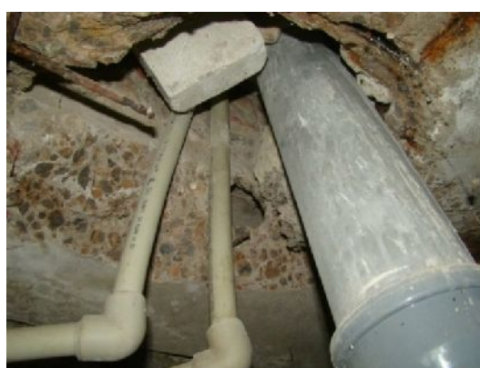
Рис. 2. Неоформленные отверстия в зонах прохода инженерных коммуникаций
