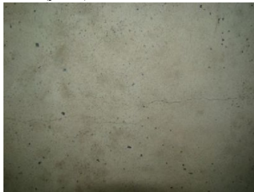
Рис. 1. Многочисленные нормальные трещины в плитах перекрытия
