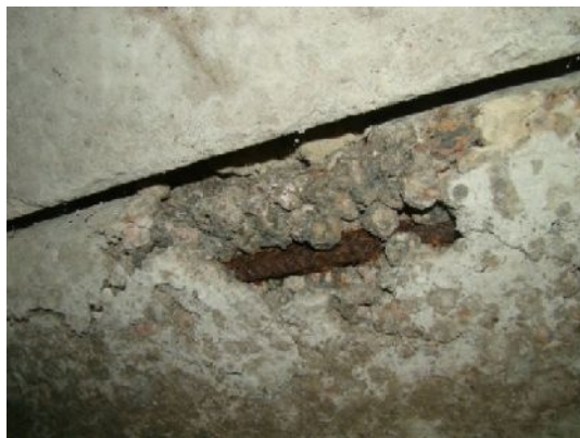
Рис. 4. Участки с неуплотнённым бетоном, непробетонированные ребра плит между пустотами на отдельных участках
