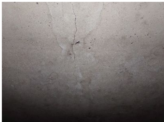
Рис. 1. Многочисленные нормальные трещины в плитах перекрытия
